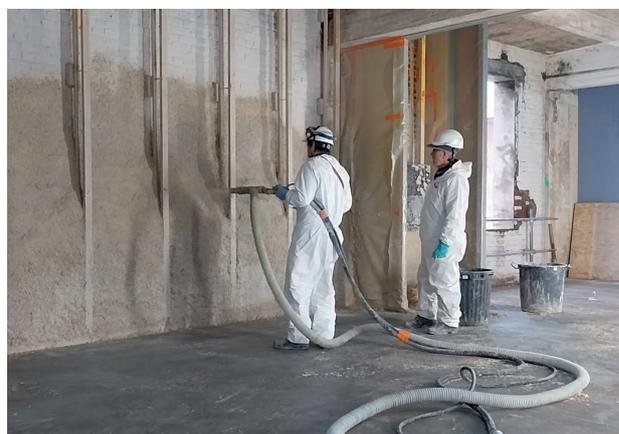
Travaux d'isolation par un enduit de chanvre
