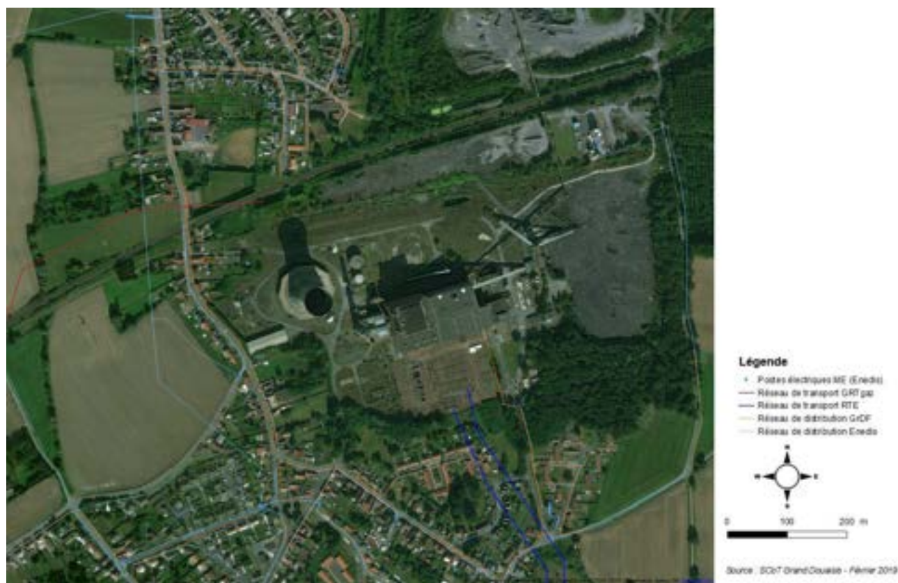
Figure 3. Centrale thermique d'Hornaing
