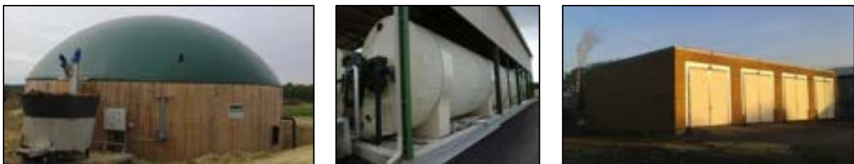
Figure 21 : Différentes technologies de digesteur pour différents types de rations (liquide, solide continue, solide discontinue – de gauche à droite)
