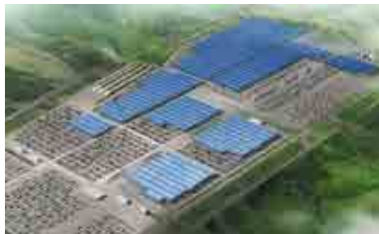
Figure 25 : Projection de l'usine Renault de Douai et des toits entièrement recouverts de panneaux photovoltaïques. 2011
