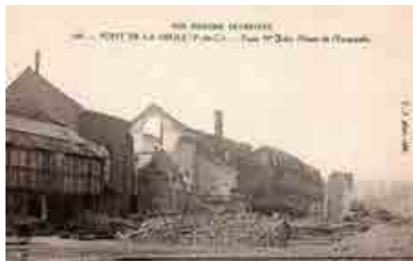
Figure 15 : Ruines de la fosse n°3 de la Compagnie des Mines de l'Escarpelle à Flers-en-Escrebieux. 1918-1919
