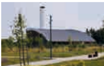
• Chaufferie biomasse du Raquet
