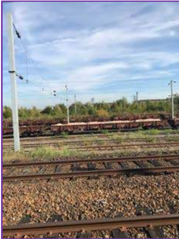
Faisceau voies de service VS 1 à 23
