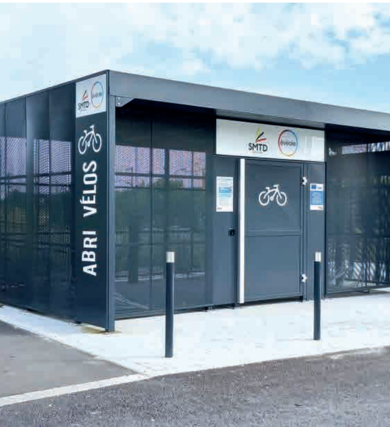
| Abri vélos sur le parvis de la gare de Sin-le-Noble
