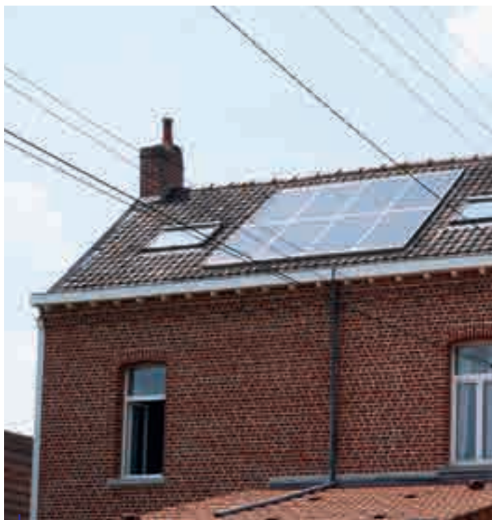
Panneaux photovoltaïques en toiture
