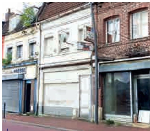
commerces et logements à Flers-En-Escrebieux
