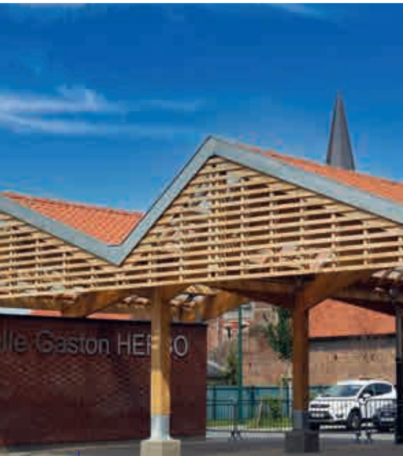
Halle à Arleux
