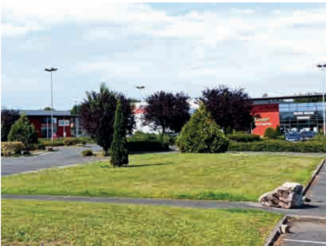
Pôle commercial de périphérie - type III - centre commercial Intermarché Masny
