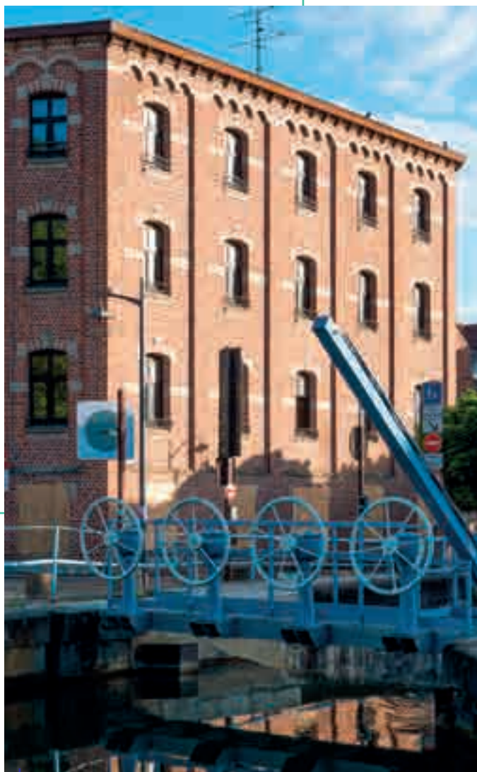
Ecluse à Douai
