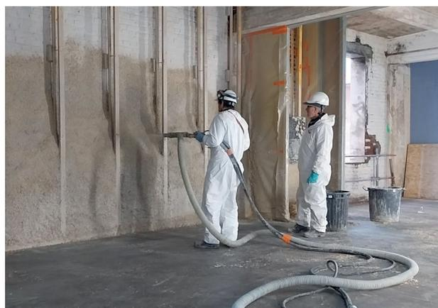
Travaux d'isolation par un enduit de chanvre
