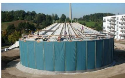
La photo<sup>19</sup> ci-dessus représente un réservoir aérien de 5 700 m<sup>3</sup> construit à Munich en 2007 pour participer en hiver au chauffage des bâtiments du lotissement voisin. La capacité de stockage est d'environ 400MWh par an, soit les besoins de chauffage de 4 300 m<sup>2</sup> de logements.
