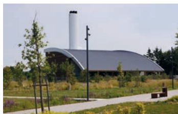
• Chaufferie biomasse du Raquet
