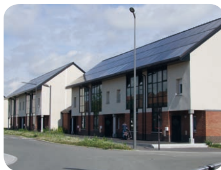
Façade principale orientée sud associée à un large patio, eau chaude solaire thermique et panneaux solaires photovoltaïques sur le toit
