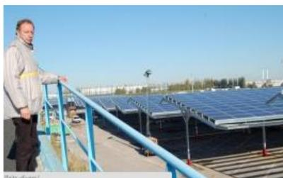
Près de 85 000 m<sup>2</sup> de panneaux photovoltaïques couvrent un parking de livraison des véhicules neufs à l'usine Renault de Douai. Ce parc permet de produire 12 mégawatts d'électricité par an, soit la consommation annuelle d'une ville de 3000 habitants.
